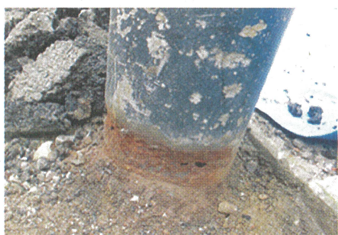
腐食が進んだ鋼管柱
