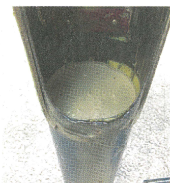
腐食が進んだ鋼管柱
